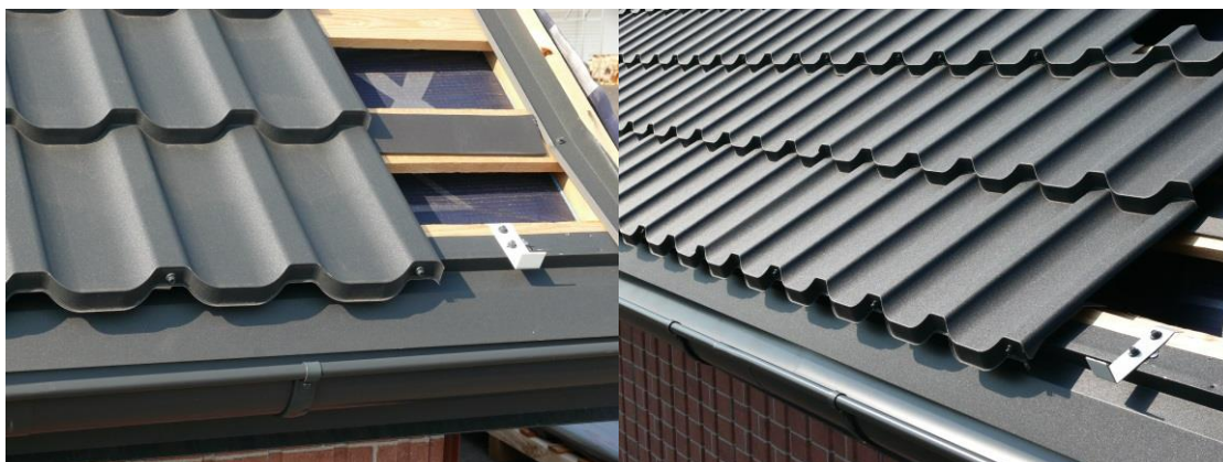
Okapové lemování pod krytinu COMAX TAŠKA MINI/Kotvící prvek krytiny COMAX TAŠKA MINI
